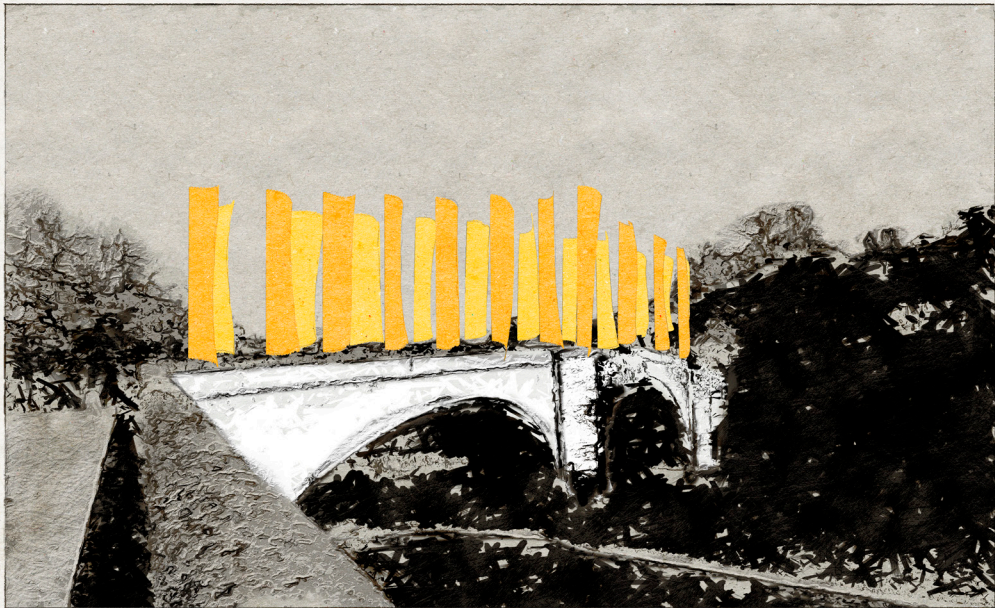
PONT DE SAINT-JEAN Pont des Langes / Freiburg / Freiburg
